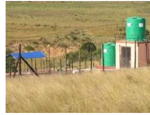
De afgeschermdde zuiveringsinstallatie
